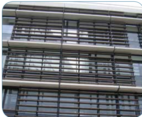
Double peau de la façade sud équipé de Brise-soleil en terre cuite et tablettes à lumière sur l'espace de circulation © Région Île-de-France, Unité Lycées
