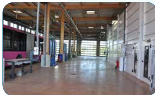
Éclairage naturel dans un atelier d'entretien et maintenance de bus et autocar - © B. PLASSE
