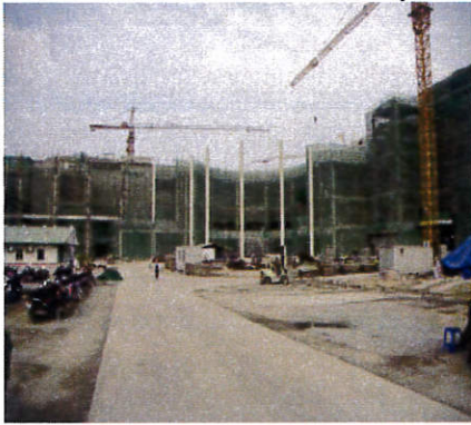
(a) : Hanoï-Est, L'Aeon Mall en construction
