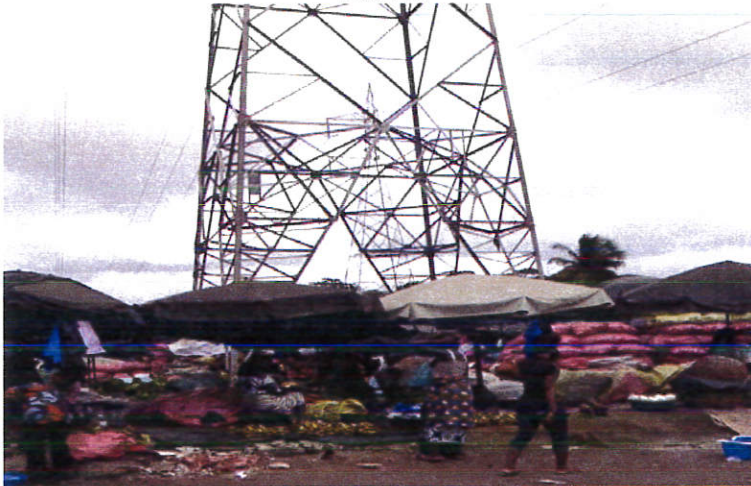
Photo 2 : Des activités commerciales en pleine expansion sous les hautes tensions
