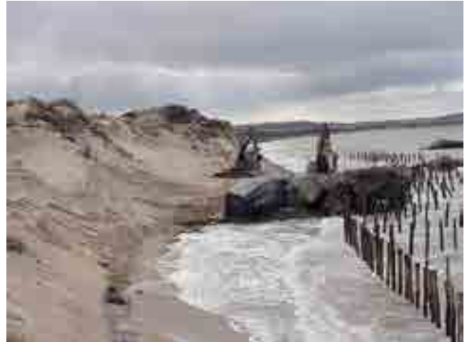
Fig. 5. Destruction de blockhaus sur la plage de Wissant (Pas-de-Calais).
