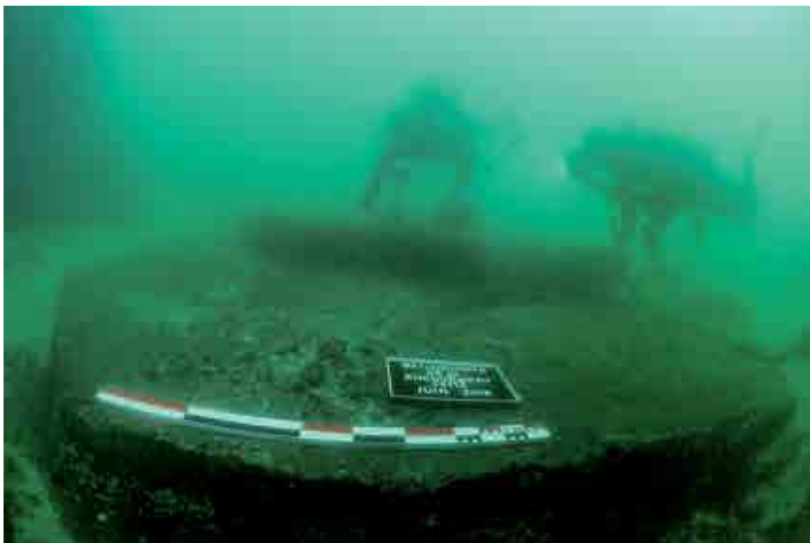
Fig. 4. Vue immergée d'un abri pour projecteur appartenant à la batterie des Gaillouneys (Gironde). Cette structure en béton repose désormais entre 10 et 15 mètres de profondeur. Opération M. Mentel (GRASMA) 2015.
