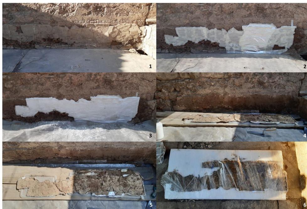
Fig. 14 Prélèvement du parement en marbre (Paroi sud du bassin froid des bains est)
