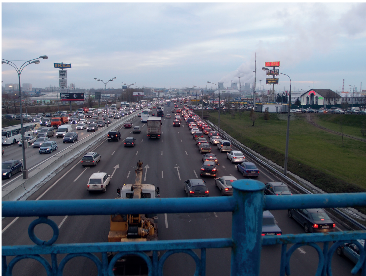
Figure 6. Sadovod, sur le troisième périphérique moscovite (kilomètre 14) Source : Y. Morvan, 2018
