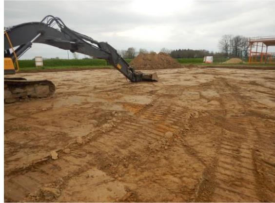
**Figure 3 :** Terrassement en vue de la construction d'une zone artisanale sur une zone humide de plateau en Bresse (Ain).
