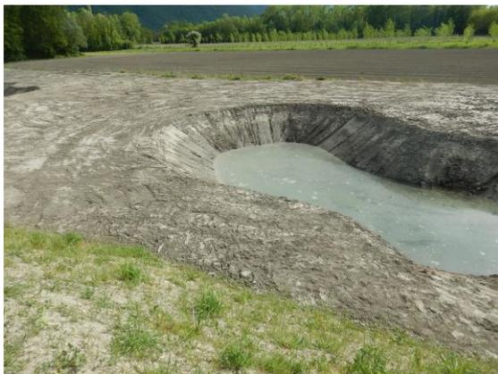
**Figure 65 :** Déblaiement insuffisant sur une zone humide alluviale dans le Grésivaudan (Isère). Le remblai a simplement été raclé en surface suite à une mauvaise compréhension du cahier des charges entre l'entreprise qui est intervenue et le maître d'ouvrage.
