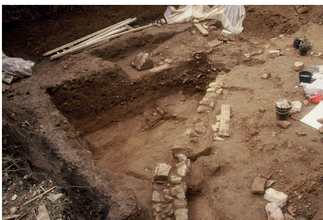
Fig.3 Le fossé F3, le muret de soutènement côté nord souligne l'élargissement de la structure d'ouest en est © D. Barthélemy.
