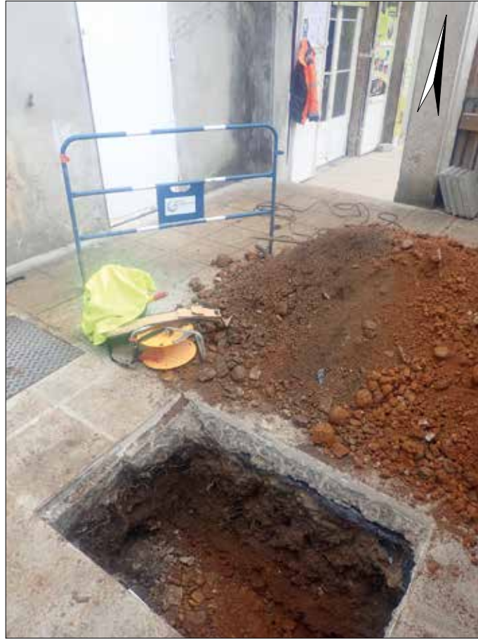
1. Vue du sondage effectué sous la terrasse du bâtiment de «France aventures»
