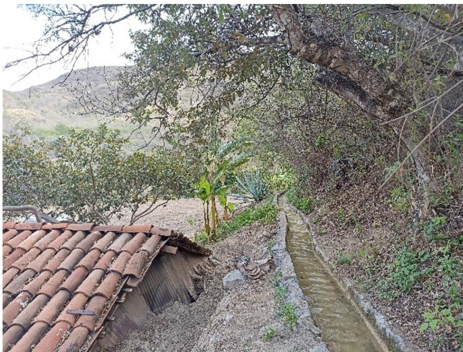
Photo 6 - Le canal cimenté dans le lieu-dit du Trapiche
