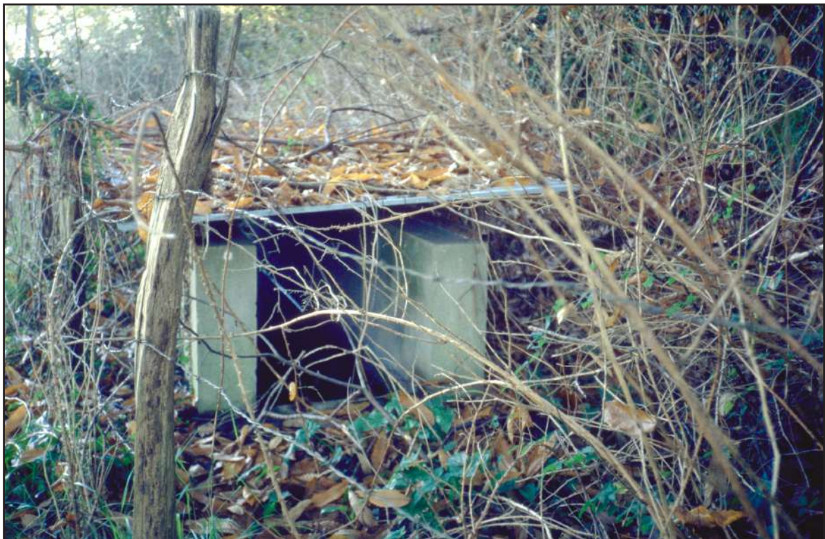
Photo 11 : La baignoire possède une toiture en PVC. Lors de notre visite, l'installation était remplie d'eau.
