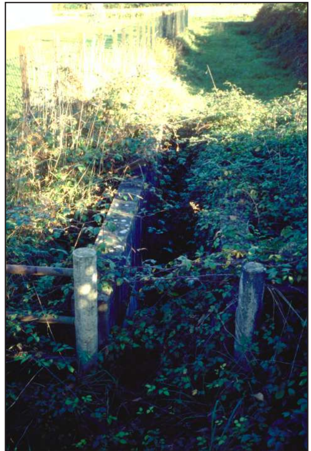
Photo 7 : La baignoire d'Alos n'est plus utilisée actuellement et la végétation envahit l'ensemble de l'installation.
