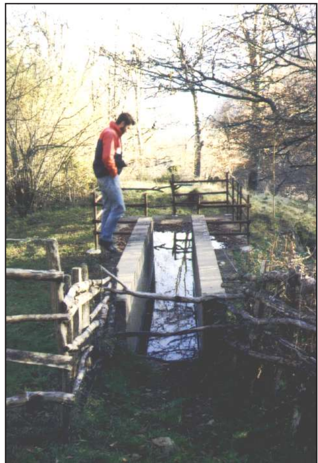
Photo 18 : L'installation qui a été réparée en 1996. La baignoire ne possède pas de parc d'attente et le 20/11/98, elle était complètement remplie par de l'eau de pluie.
