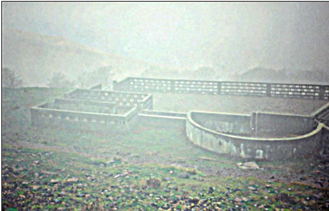
Photographie 17 : la baignoire est utilisée de façon irrégulière. Les installations sont en bon
