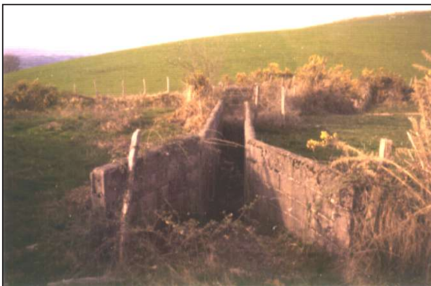
Photo 19 : La baignoire est abandonnée actuellement comme en témoigne la végétation qui envahit l'installation. Les parcs d'attente et d'égouttage tombent en ruine (novembre 98).
