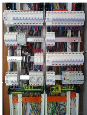
Une armoire électrique avec des départs à mesurer (il faut un peu de place sous chaque départ)
