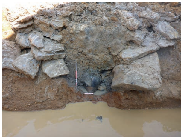
Vue en coupe du puits F10436 - partie inférieure avec vase de puisage tombé au fond du puits
