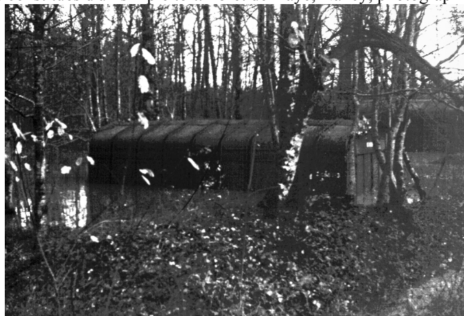
Figure 8 : un hangar métallique de type Fillod au dépôt de Trois-Fontaines près de Robert-Espagne (Meuse) pendant la décennie 1950-1960. Collection privée.
