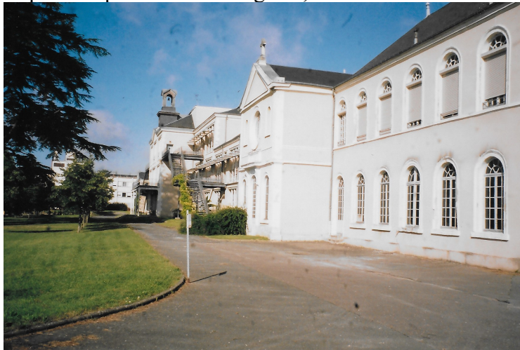
Figure 4 : la façade de l'ancien hôpital de La Chapelle Saint-Mesmin. Photographie P. Labrude, 2007. Au fond à gauche, une extension construite par l'armée des Etats-Unis.
