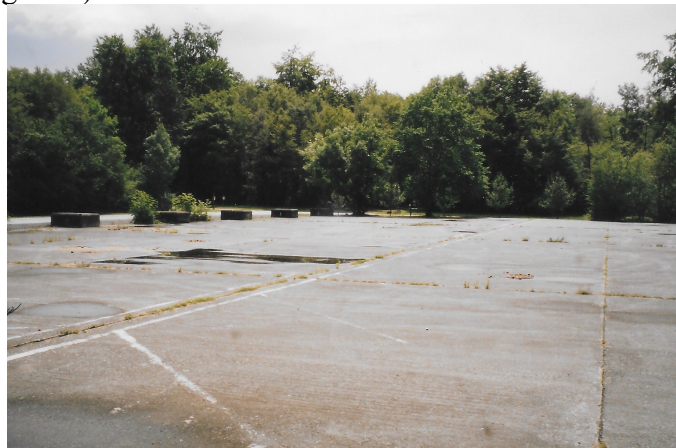
Figure 7 : les dalles de béton constituant l'assise et le sol, et les blocs du même matériau qui supportaient les piliers des hangars constitués d'un simple toit. Forêt de Haye, Nancy, photographie P. Labrude, 2007.
