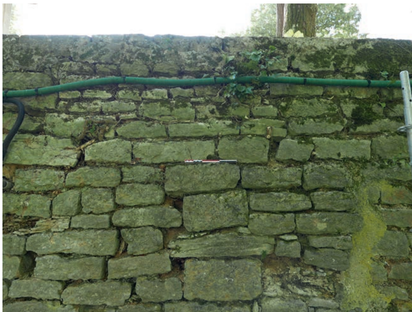
ill. 22 : Sondage SRA 12 en partie haute : limite horizontale entre les maçonneries de construction et celles de la reprise du garde-corps.
