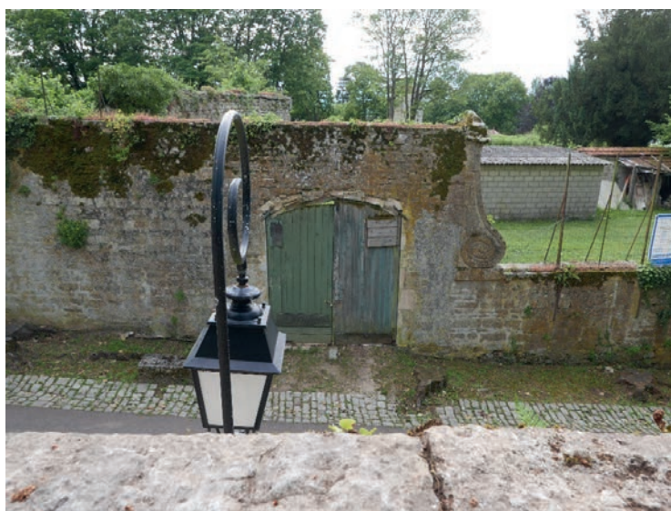
Portail d'accès aux jardins sud-est, le long de la rue Clémenceau, en face de la porte murée de l'UM5 (le cliché a été pris à l'aplomb de cette porte murée)
