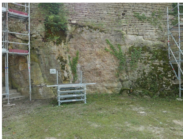
ill. 17 : Le rocher naturel au SUD de la poterne présente des litages qui facilitent l'extraction des blocs pour la préparation des fondations.
