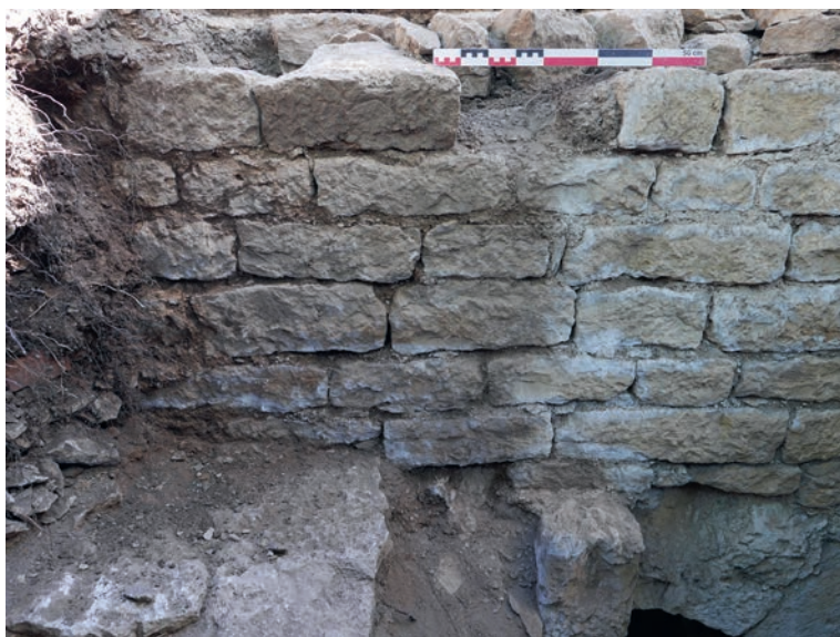
ill. 14 : Parement sud de l'arche, mis en œuvre à l'aide d'un petit appareil de moellons taillés.
