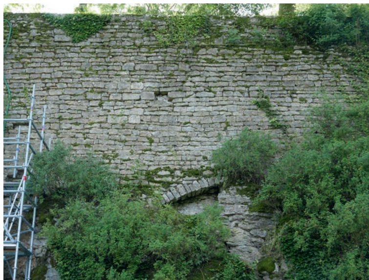
ill. 19 : Dans le mur de terrasse UM 1 au nord de la poterne, des dispositifs d'arche clavées permettent aux maçonneries d'enjamber les irrégularités de la roche naturelle.
