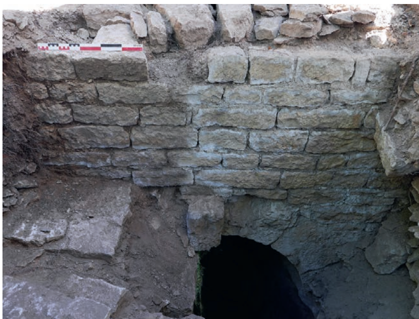
Maçonnerie de l'arche la plus au sud, parement sud (US100.2) (en haut, l'assise est constituée des queues des blocs formant le parement nord)
