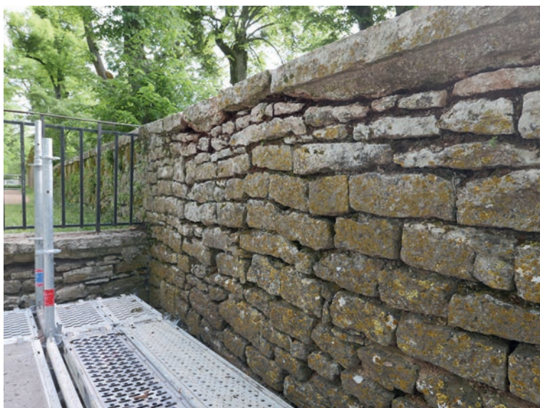
ill. 18 : Maçonneries de la poterne en partie haute : couvertines sur le mur qui longe l'allée Clémenceau UM 5.
