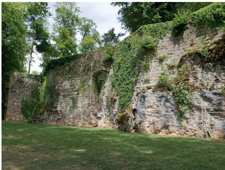
ill. 1 : Mur ouest de l'enceinte du parc : les maçonneries épousent le pendage de la roche naturelle.
