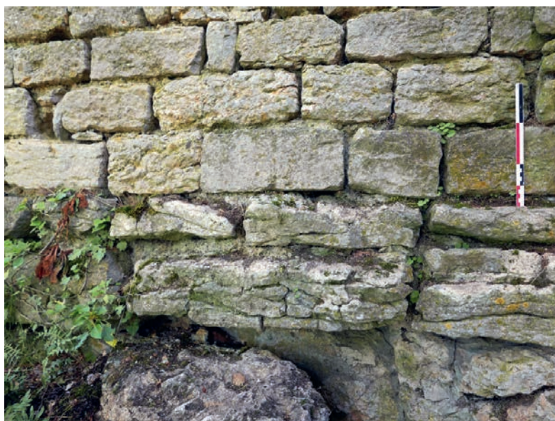
SRA11, UM1 : semelle de fondation composée de roche délitée, maçonnée à l'aide de mortier de chaux : l'élévation est posée légèrement en retrait sur cette fondation
