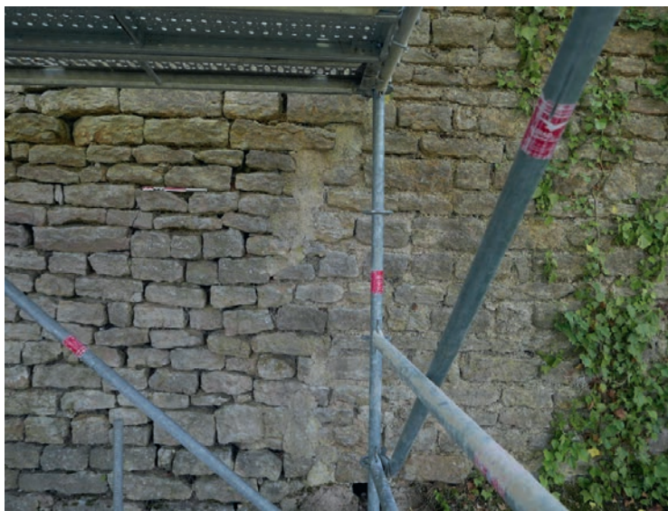
UM1 : césure verticale entre UC1.3 et UC1.7. recimentée en surface
