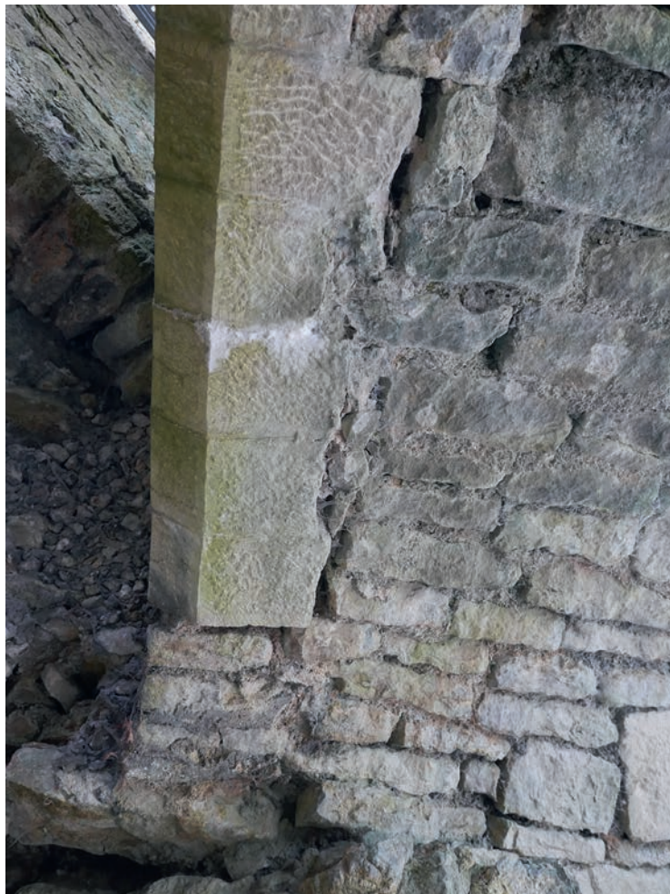
Figure 76 : a. Poterne, maçonneries de l'arche vues depuis le nord (UC 10.5) ; b. Détail des claveaux taillés et chanfreinés de l'UC 10.5.
