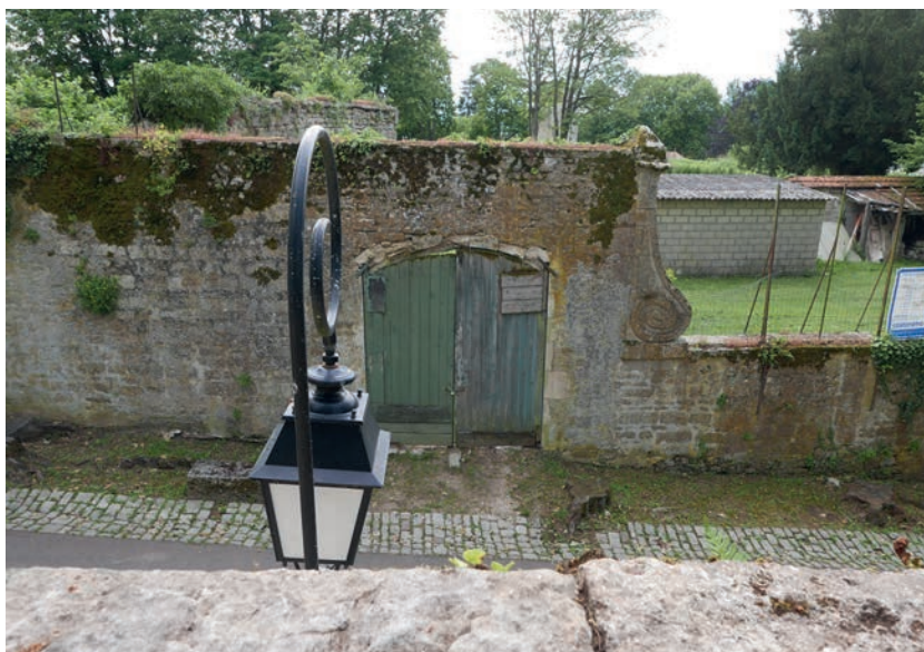
ill. 21 : Porte d'accès au potager à l'est de l'allée Clémenceau, vue depuis l'échafaudage de la poterne à l'aplomb de la porte au linteau en bois du mur UM 5.
