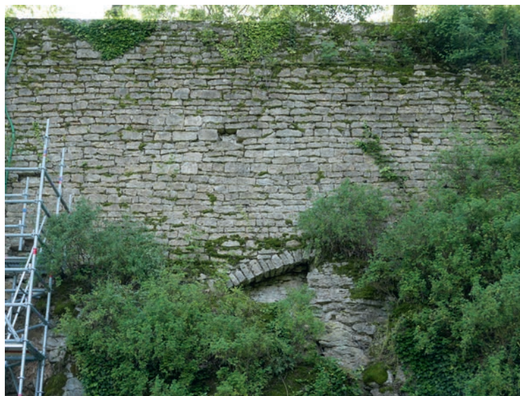
ill. 19 : Dans le mur de terrasse UM 1 au nord de la poterne, des dispositifs d'arche clavées permettent aux maçonneries d'enjamber les irrégularités de la roche naturelle.
