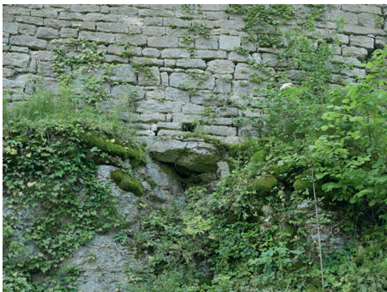
ill. 8 : Détail des maçonneries du mur UM 1, qui reposent sur une dalle intermédiaire permettant d'enjamber une faille.
