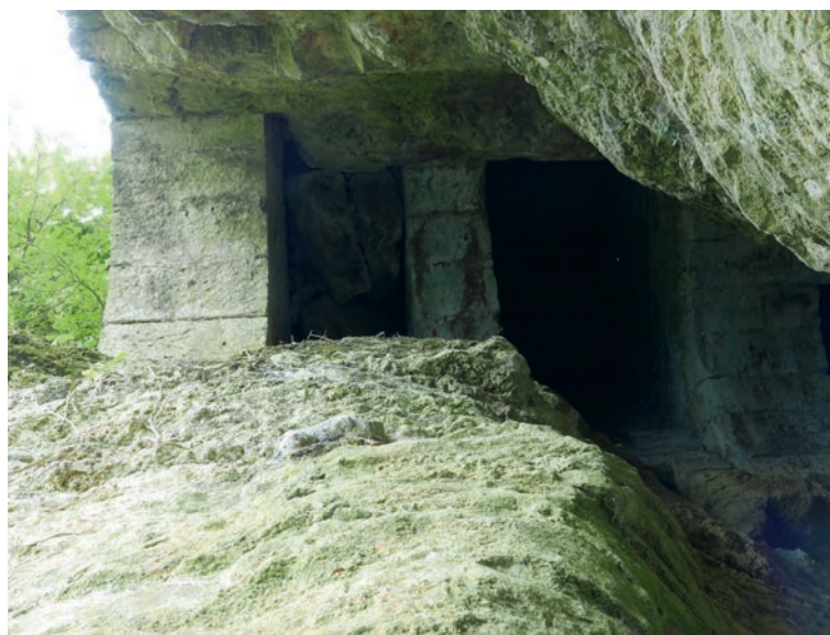
ill. 15 : Les trois arcs en pierre qui enjambent la faille, vus depuis la terrasse inférieure.
