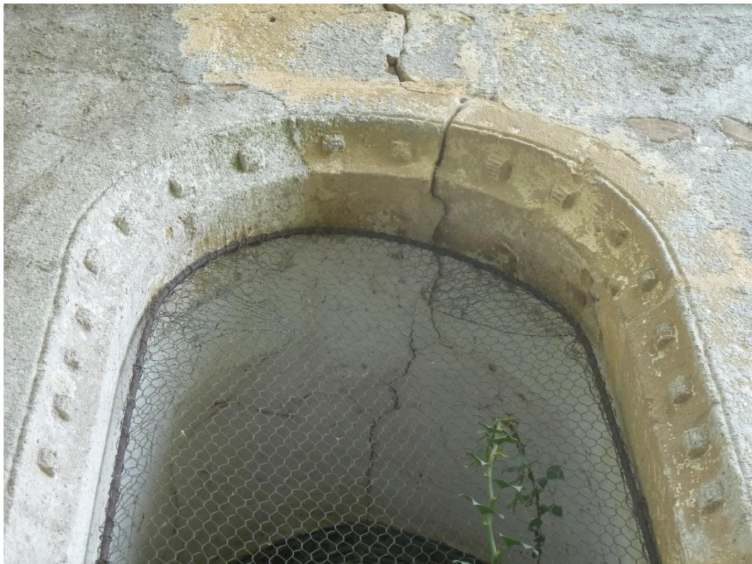
Fig. 12 : Église de Bastanous, le chevet, la fenêtre de droite (Cl. C. Balagna)
