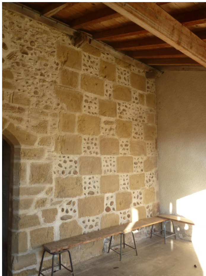
Fig. 26 : Église de Bastanous, élévation du mur sud, à droite du portail (Cl. C. Balagna)
