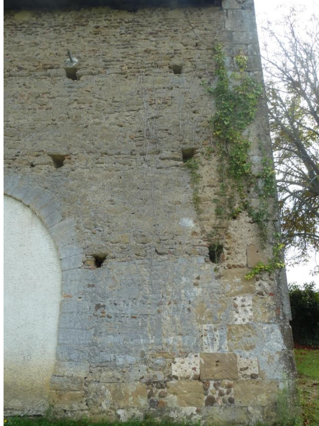
Fig. 17 : Église de Bastanous, élévation nord, détail de l'angle nord-ouest (Cl. C. Balagna)
