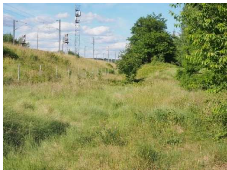
Figure 20 : Bassin d'expansion des eaux de crue de la Marne de la LGV à Vaires-sur-Marne (gestion raisonnée), Département de Seine-et-Marne (Coordonnées géographiques : 48°52'38.3"N+2°39'37.2"E). © Pierrette Nyssen
