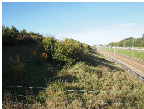
Figure 25 : Enclos de pâturage sur les talus de la LGV à Herve, Province de Liège (Coordonnées géographiques : 50°38'01.2"N+5°47'17.3"E). ©Pierrette Nyssen
