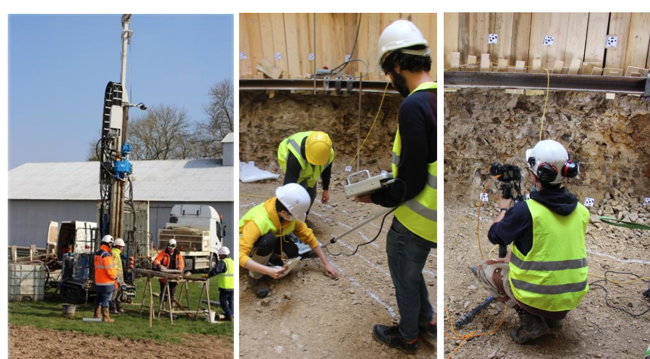
Investigations géotechniques et géophysiques
