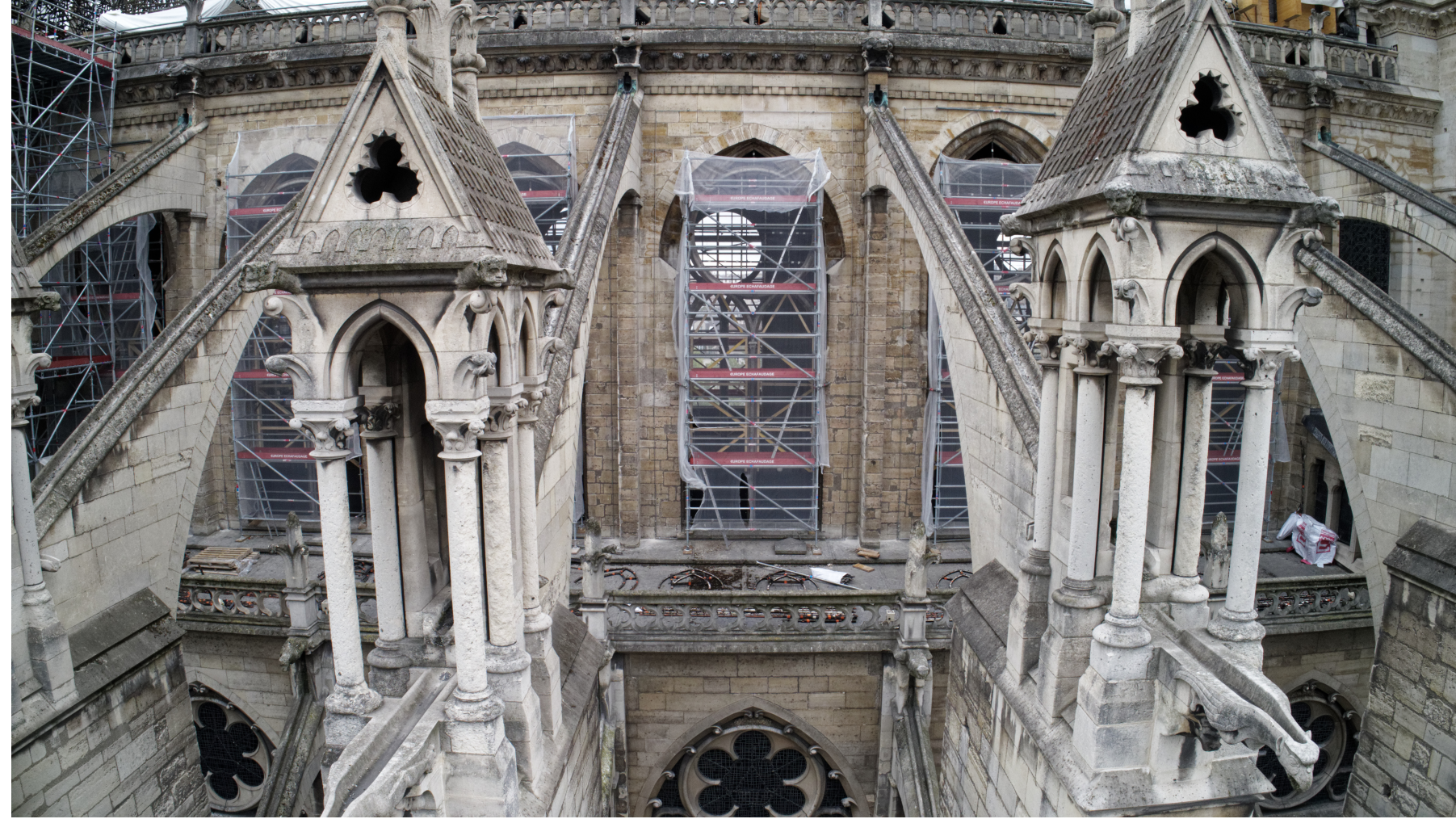
Acquisitions photogrammétriques avant incendie (drone et boîtier ; source : AGP)
