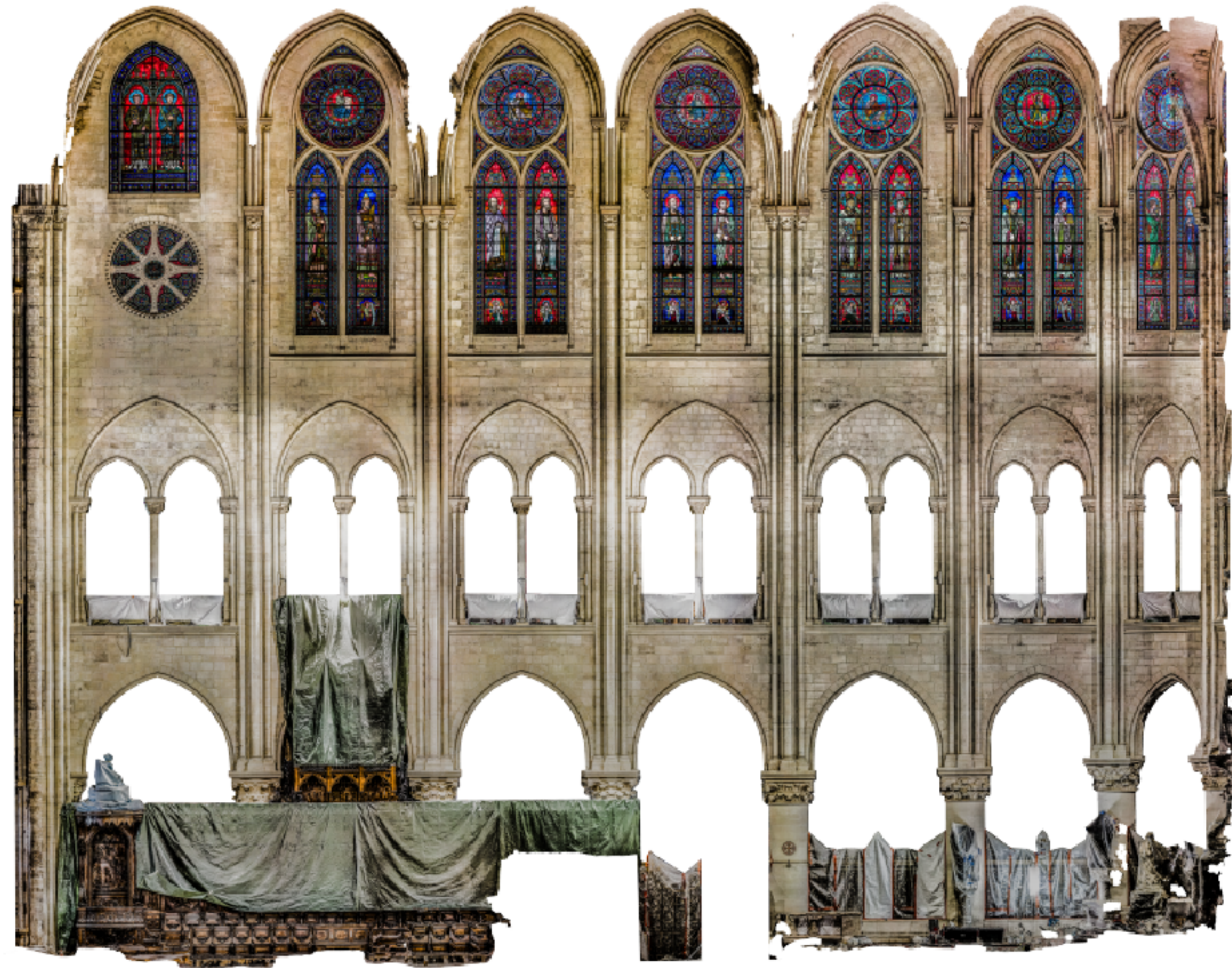
Photogrammétrie au drone – Mur nord du chœur
