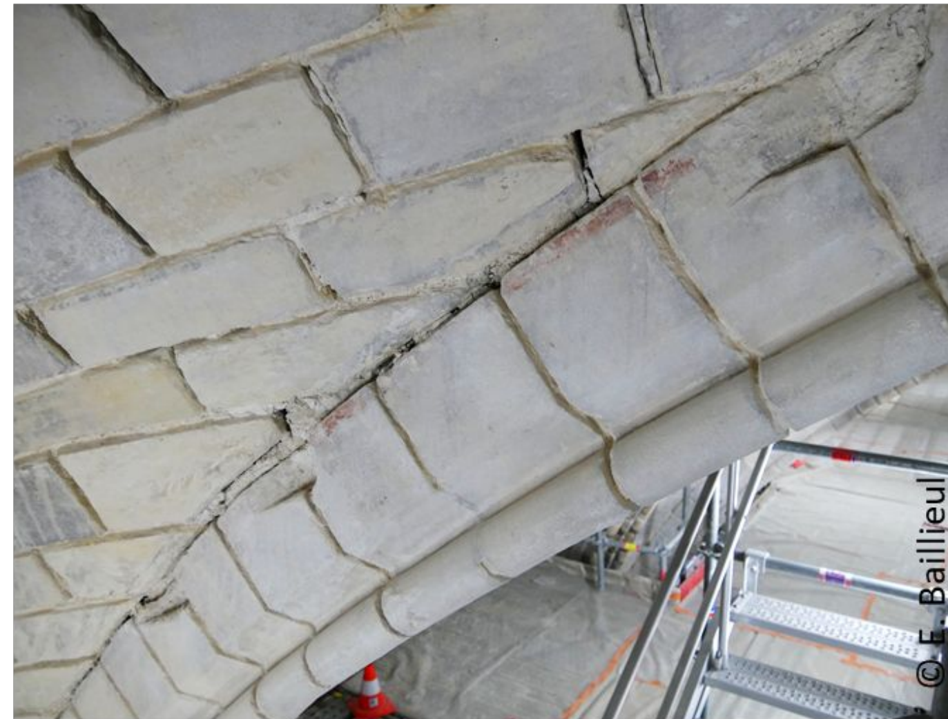
Observation directe des voûtes du chœur (en haut) et de la nef (en bas) au moment de la réfection des joints
