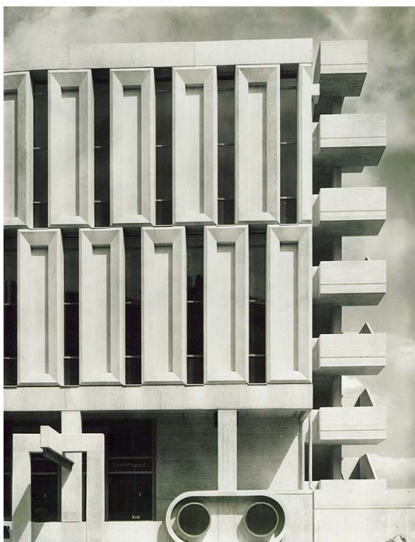
Centre téléphonique de Fontenay-sous-Bois (Val-de-Marne), Société civile d'architectes Lods, Despont, Beauclair, photographie de Claude Garnier, 1969 (dossier de carrière d'Henri Beauclair, AN, 19800126/4).
