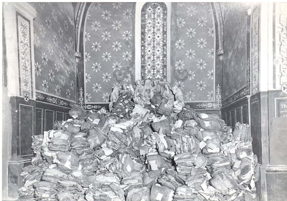
Vue de l'abside d'une chapelle latérale dans l'église conventuelle, affectée au stockage d'archives, vers 1950.
