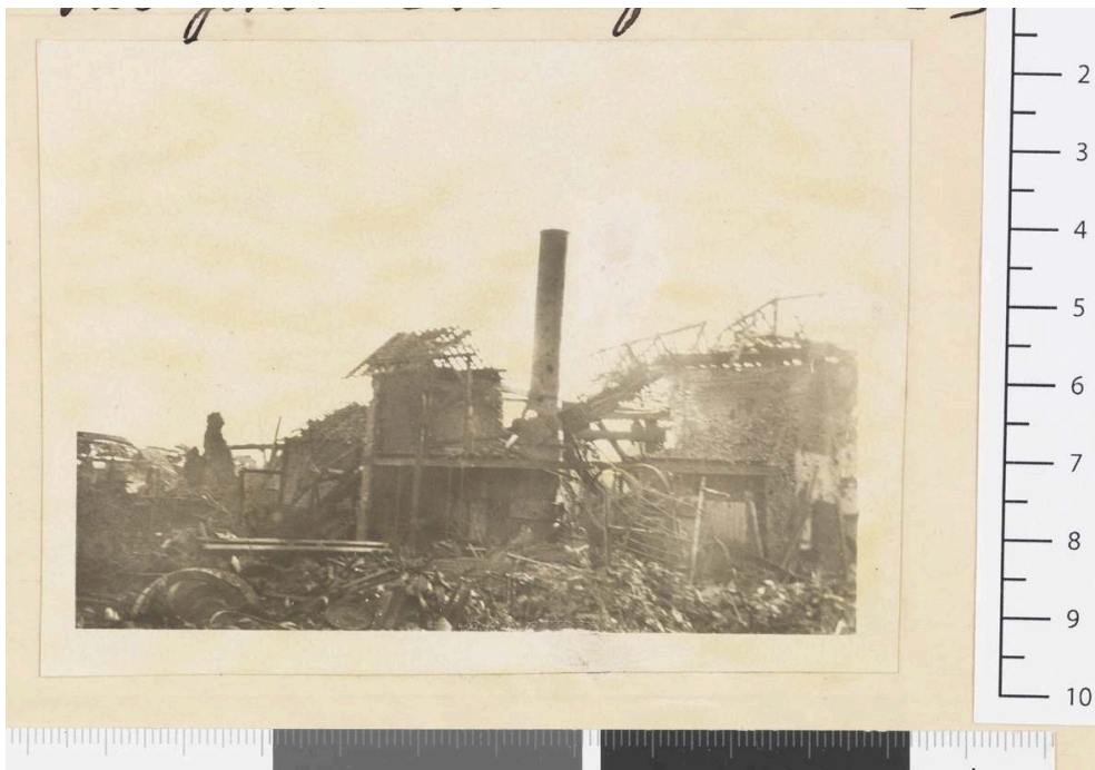
Vue générale de la fonderie, 1919, auteur inconnu. © Archives nationales, 2014.
