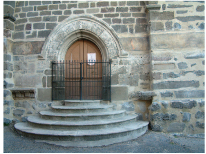
Fig. 7. Saint-Vidal, l'église et les blocs antiques réemployés.
