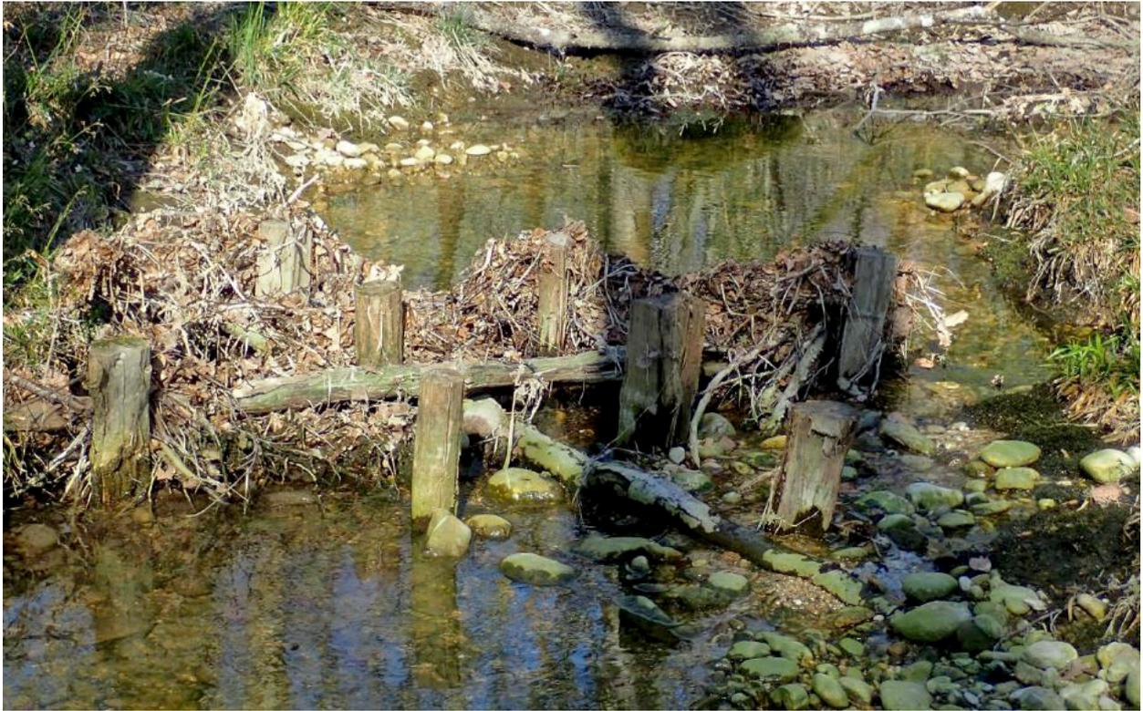
**A1-5. Photo du rehaussement de la lame d'eau d'un affluent méandrique mais curés à l'aide de triplet de bancs de graviers galets (recharge)**
