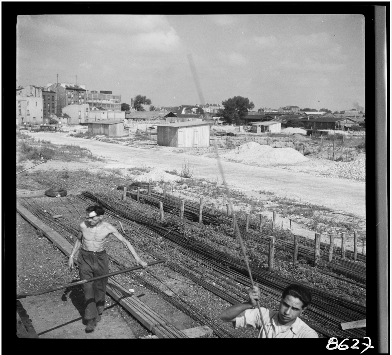
Figure 2: Constructions du troisième immeuble, chantier des ISAI - Saint-Denis - 1945, Crédits photo : André-Louis Guillaume - Terra
