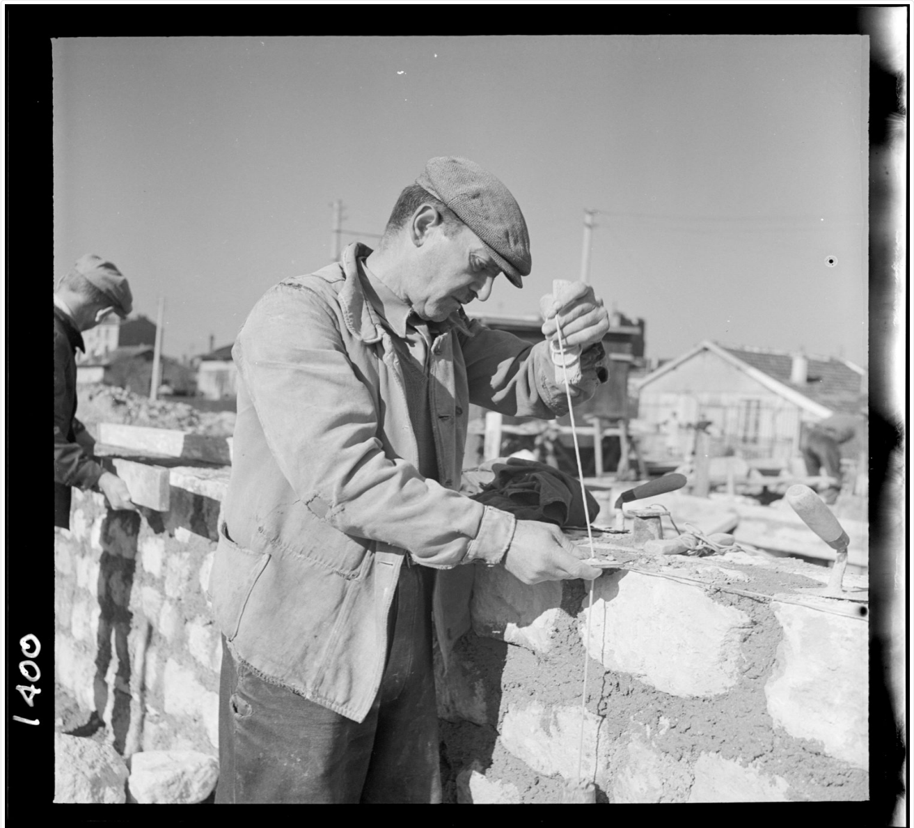
Figure 1: Chantier d'expérience de Noisy-le-Sec - Cité expérimentale de Merlan - 1945, Crédits photo : André-Louis Guillaume - Terra
