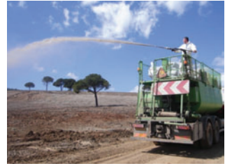
Épandage de l'amendement (à gauche) et ensemencement par hydroseeding (à droite)
