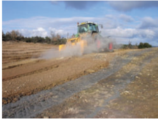
Épandage de l'amendement (à gauche) et ensemencement par hydroseeding (à droite)
