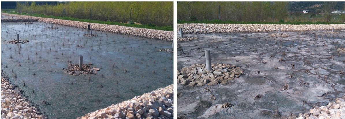
Figure 1. Flaquage prolongé sur un filtre en alimentation (à gauche) et dépôt de boues séchées sur le filtre au repos depuis plus de 7 jours (à droite), sur le 1 er étage d'une station jeune démarrée en hiver et recevant une très forte charge organique.
