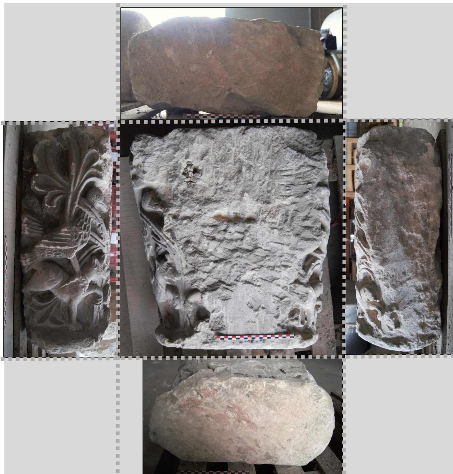
Figure 38 - Bloc 72.4.4, face supérieure avec lit de pose, face latérale droite entièrement sculptée, face principale buchée, face latérale gauche avec éléments sculptés conservés, face inférieure avec lit de pose. © E. Chargé.
