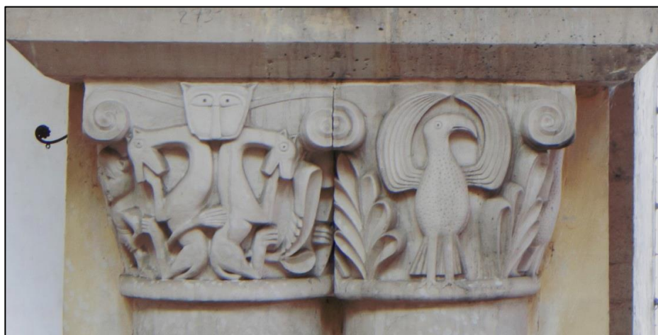
Figure 29 - Vue des chapiteaux A13 et A14 dans l'abside de l'église Saint-Martin-au- Val. © E. Chargé.
