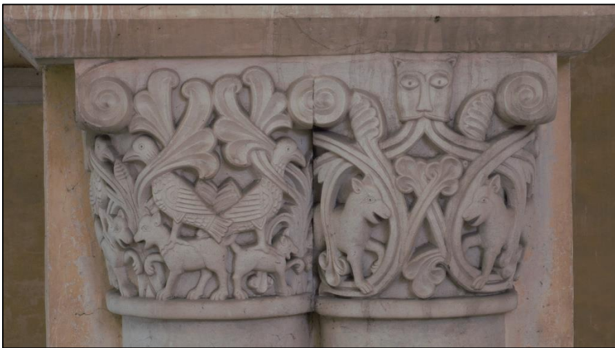
Figure 40 - Vue des chapiteaux A9 et A10 dans l'abside de l'église Saint-Martin-au-Val. © E. Chargé.
