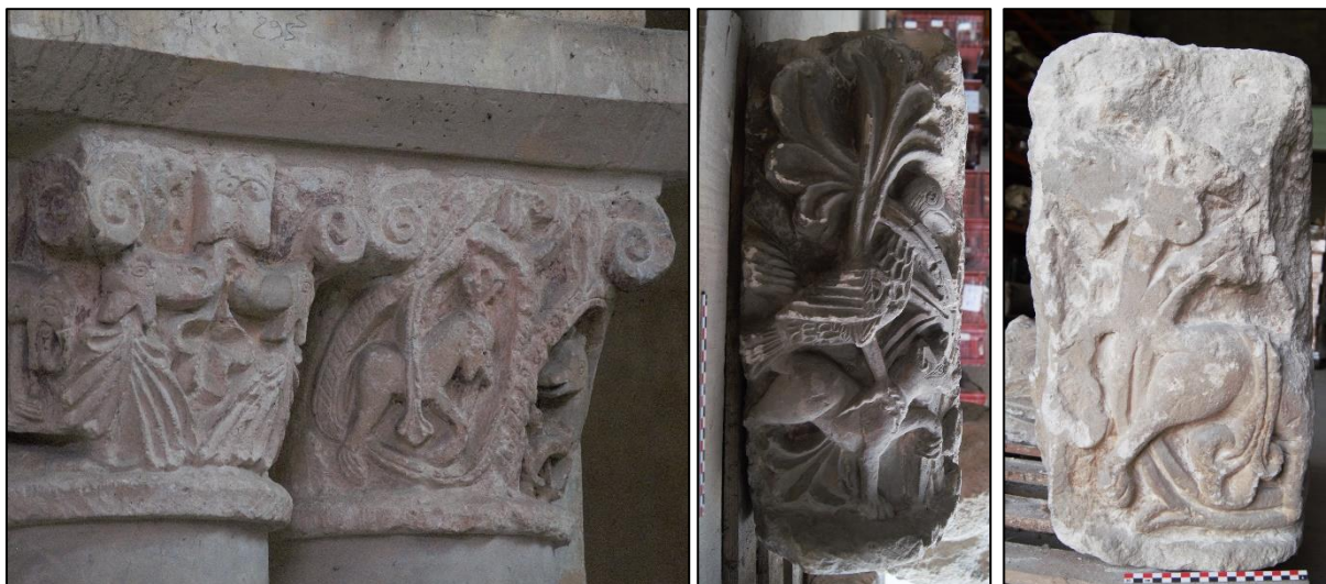
Figure 107 - Vue des chapiteaux de l'abside et pièces déposées (de gauche à droite) : A5 et A6, inv. 72.4.4 (A9), 72.4.5 (A10). © E. Chargé.
