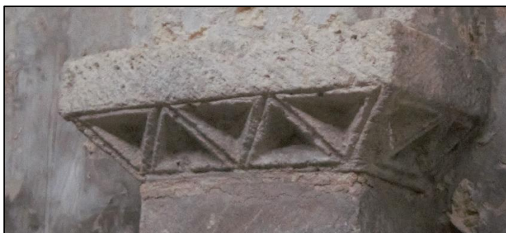
Figure 78 - Tailloir du pilastre CR8. © E. Chargé.
