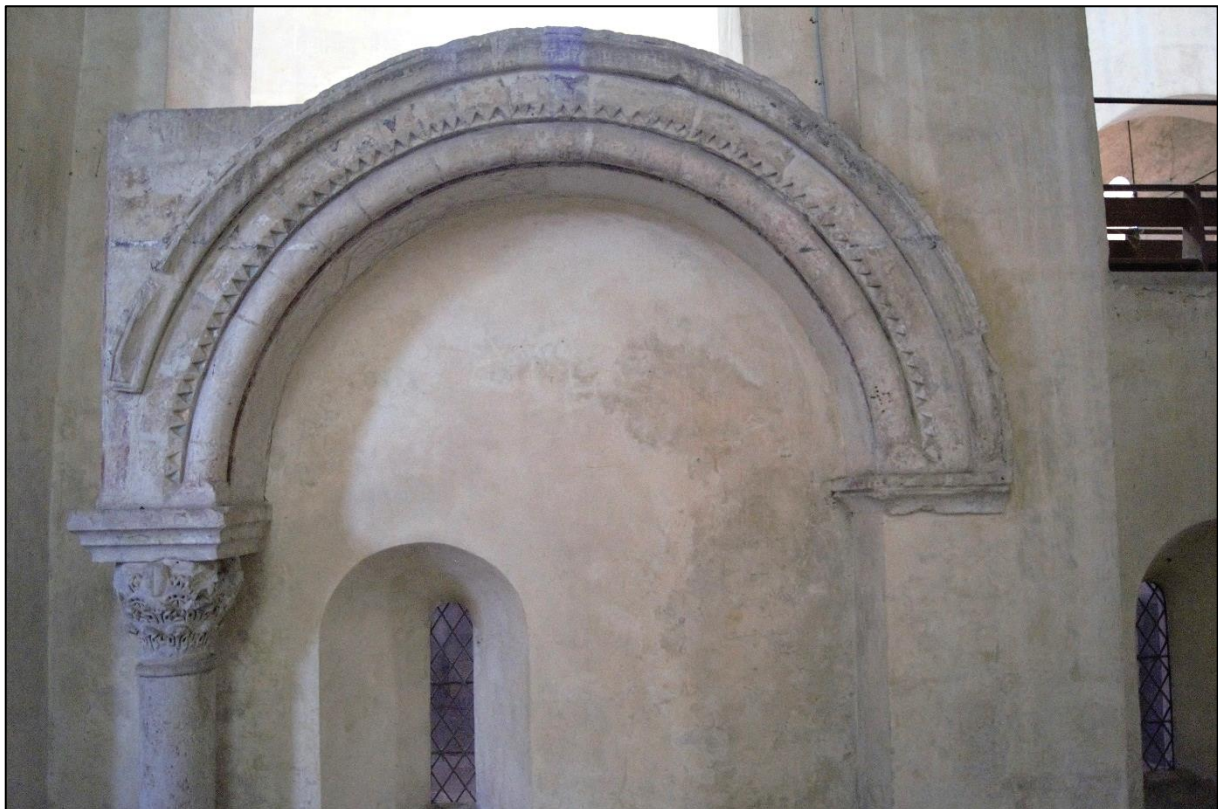
Figure 50 - Arc plaqué contre l'abside au nord-ouest du déambulatoire. © E. Chargé.
