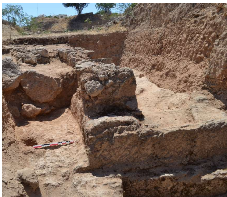
Fig. 24 et 25. Le mur de soutènement avant et après le démontage de son extrémité conservée à l'Ouest. Vues vers l'Est. Cliché : M. Tastayre/Mafap.
