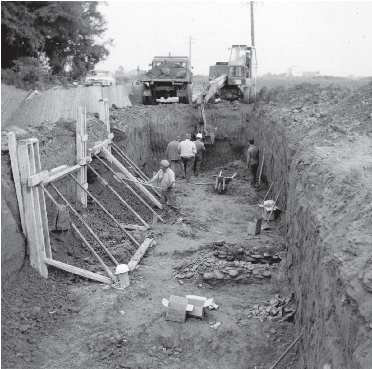
Ouverture d'un sondage à I Ponti (Lucciana)
