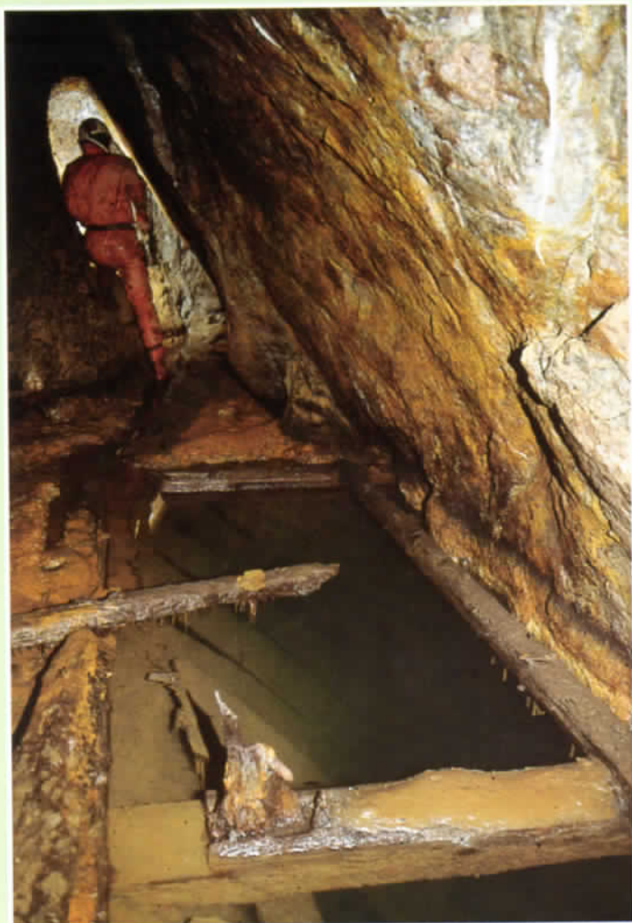
L'eau a conservé les boisages de ce puits, mais le treuil a disparu.
