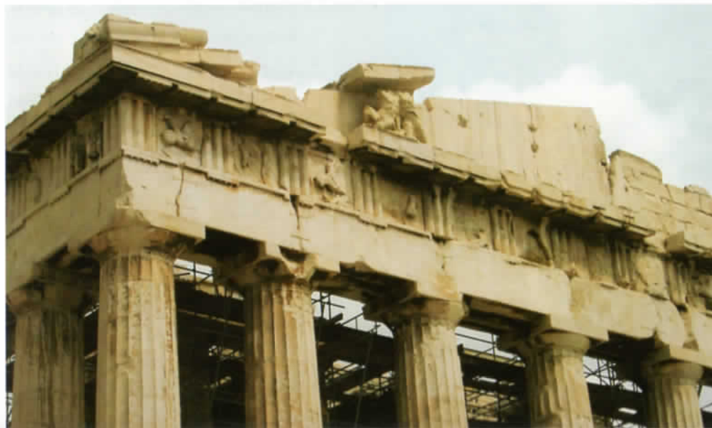
L'assemblage des blocs et des colonnes du Parthénon, à Athènes, a été effectué à l'aide de crampons de fer scellés au plomb.
