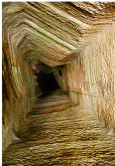
Puits de mine du Laurion taillé dans les marbres.
