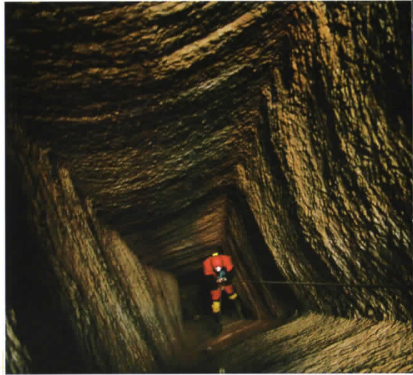
Les traces d'aménagement sont bien visibles dans la paroi de ce puits. Ces encoches servaient à fixer les boisages.
