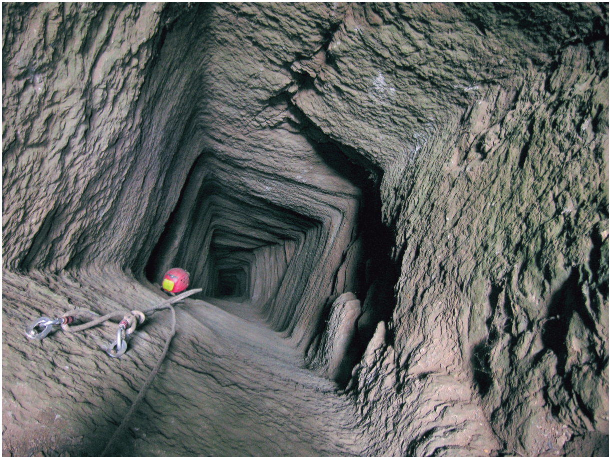
Fig. 2. Laurion (Grèce). Secteur Spitharopoussi. Puits quadrangulaire. Vue depuis la surface (Puits Perséphone – Nic 4. Puits vrillé. Profondeur = 109,50 m). Photographie D. Morin.
