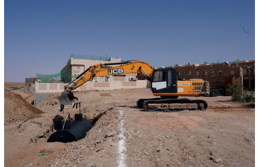
Installation d'une station d'épuration décentralisée à Ghardaïa
