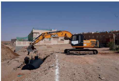
Installation d'une station d'épuration décentralisée à Ghardaïa
