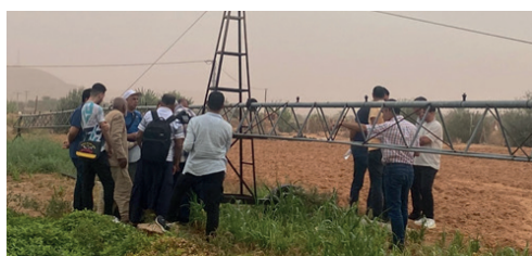
Visite d'un pivot d'irrigation en Algérie
