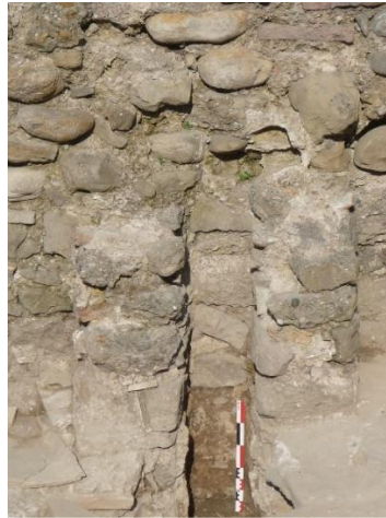
Fig. 25: le drain vertical contre le mur périphérique des tabernae (RAFAD 2019)
