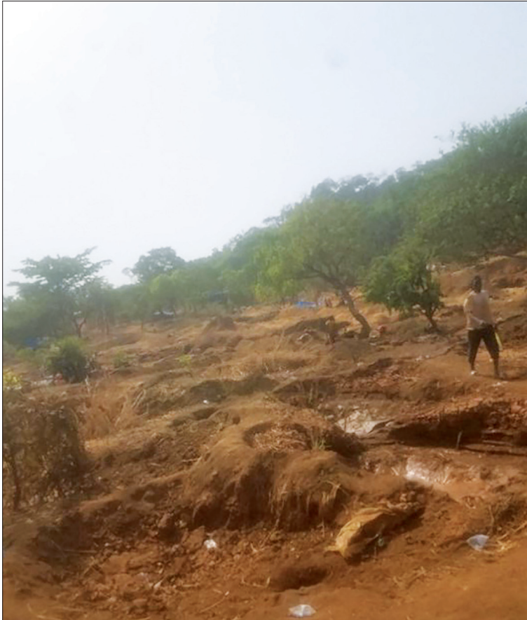
Photo 1. Excavation des terres à Saman (Kouroussa, Guinée)
