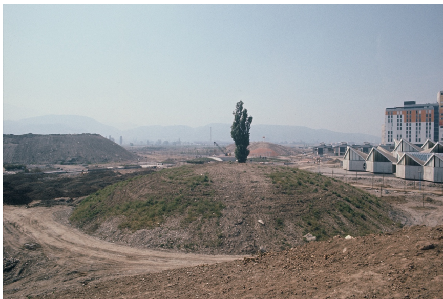
Figura 6. Villeneuve de Grenoble, Parc Jean Verlhac em construção no início dos anos 70 Foto: Honoré Paris (agradecimentos Marion Paris)
