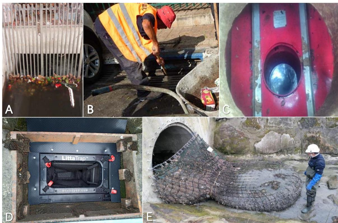
Figure 20 : Photos des différentes infrastructures de collecte de déchets (A : dégrilleurs, tiré de Rognard & Finck, 2020 ; B : avaloir sélectif, tiré de Pasternak et al., 2021 ; C : séparateur hydrodynamique, tiré de Malik et al., 2021 ; D : bac de récupération, tiré de Martinez & Griffiths, 2023 ; E : filet, tiré de Tramoy et al., 2022a) utilisées dans les études sur les flux de déchets à l'exutoire des réseaux pluviaux.
