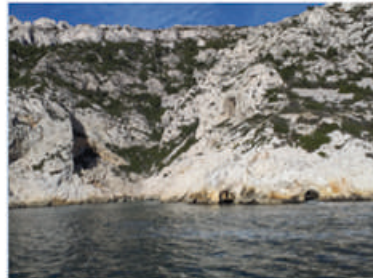
Photo 4 : L'émissaire de Cortiou, rejetant les eaux usées et eaux de pluie de Marseille, au cœur du Parc national des Calanques. Une odeur particulièrement nauséabonde embaume les lieux. Photo : Cadoret A., février 2019
