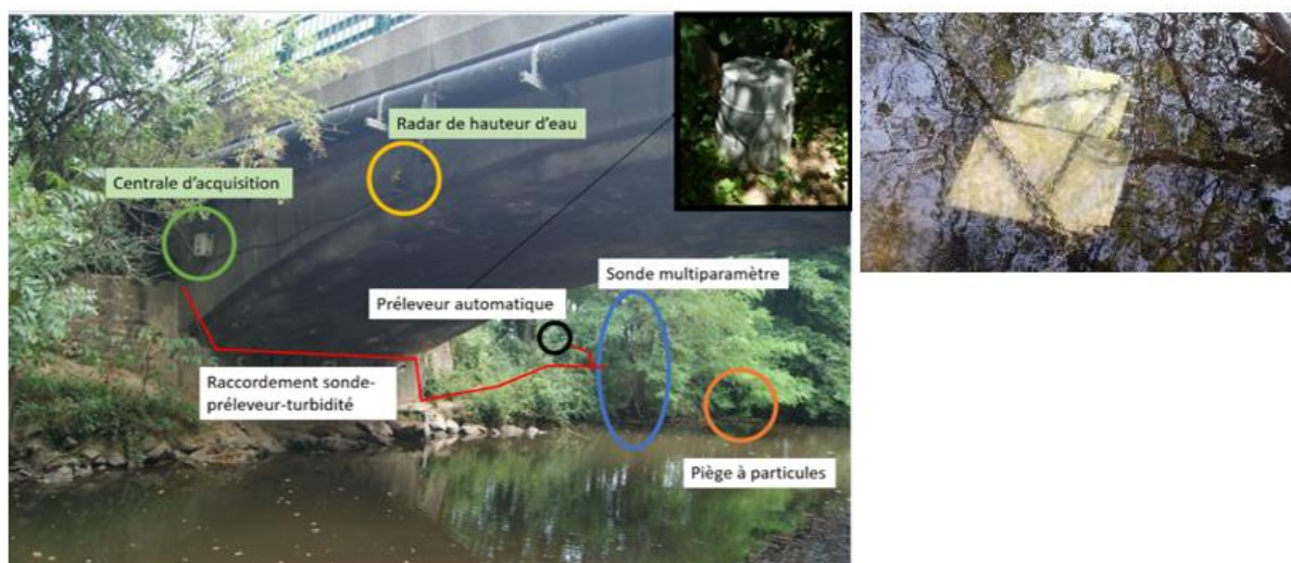
Figure 14 : A gauche, dispositif expérimental au Pont de Pizay, emplacement des deux Pièges à Particules. A droite : Pièges à particules immergés.
