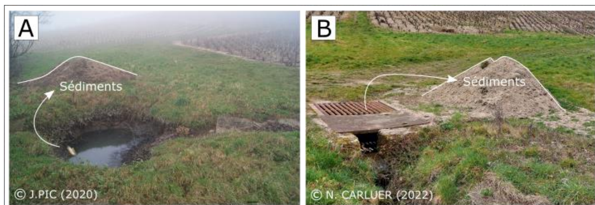
Figure 6 : Exemples de pièges à sédiments (Villié-Morgon, Beaujolais). A – Mare ayant été curée. B - Bac décanteur ayant été curé. (Pic, 2023)
