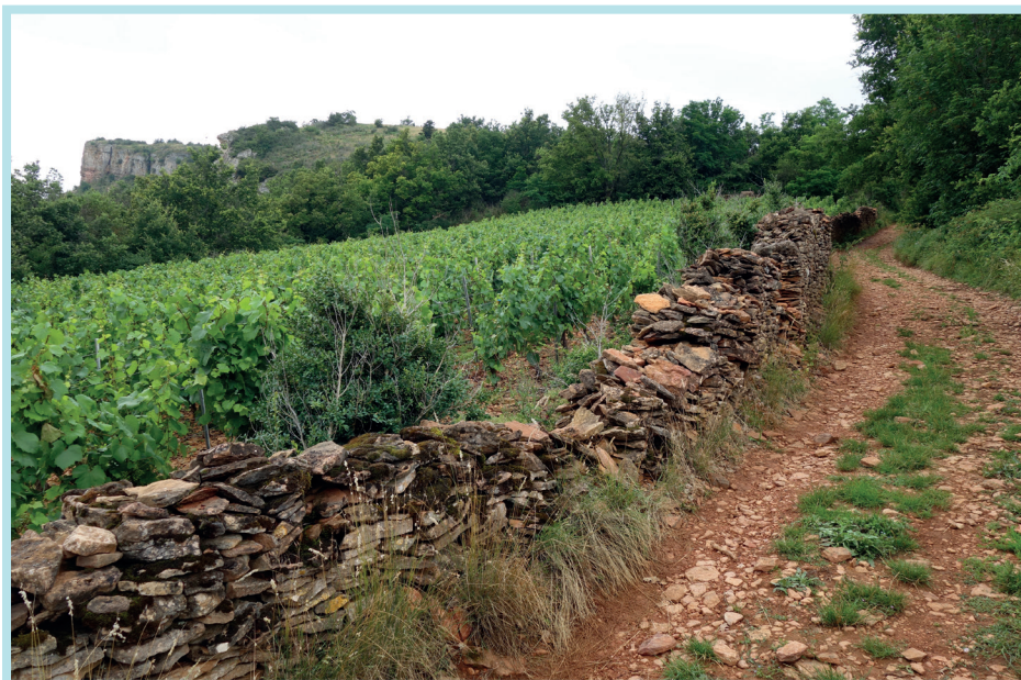
Muret écroulé et vignes au pied de la Roche de Solutré dans la brume. Clément Nicolas Roques, juillet 2021.
