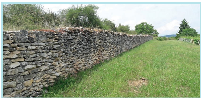
Muret de soutènement en partie restauré par la brigade verte. Gwenaëlle Richard, juin 2017.
